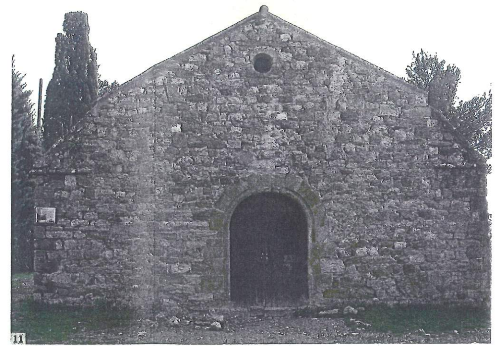
Fig. 11 Façade occidentale de la chapelle comportant un portail en plein-cintre surmonté d'un oculus (Cl. M. Vecchione).
