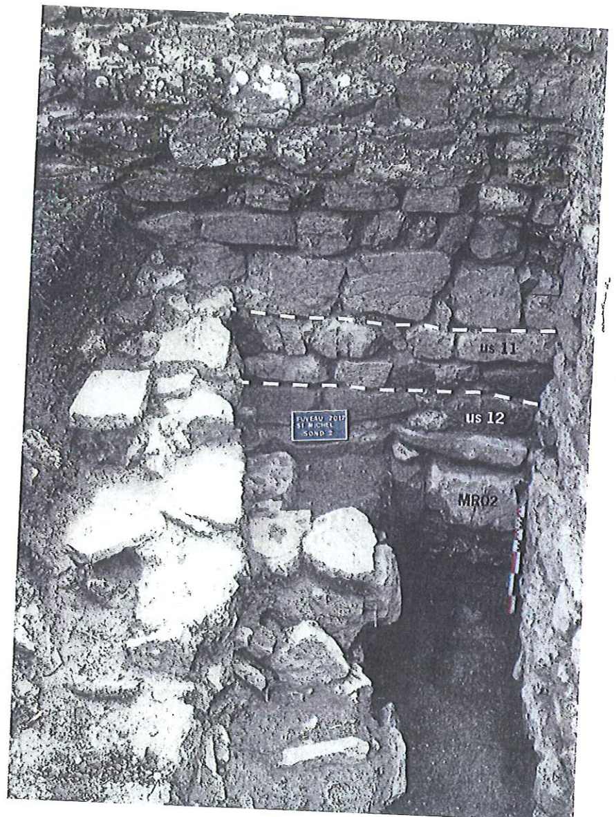
Fig. 32 Partie basse du mur MR02, fondation ou maçonnerie antérieure? (Cl. M. Vecchione).
